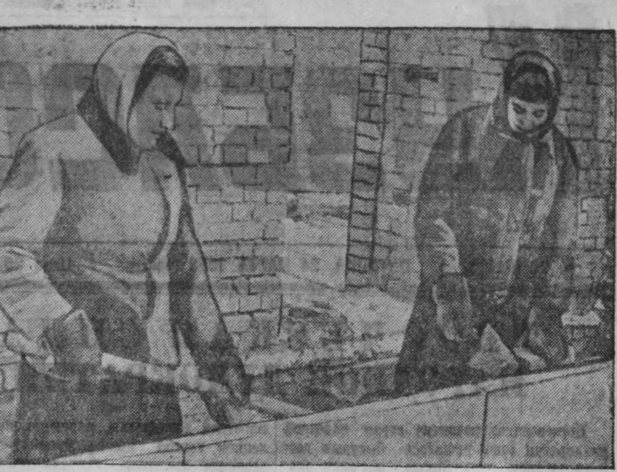
Комсомолки-каменщицы стройуправления «Жилстрой» треста «Сталинскромстрой» Ефросинья Прикащеникова и Татьяна Волкова выполняют план на 180—200 процентов.
