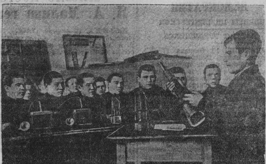
На занятиях в горнопромышленной школе № 38 г. Прокопьевска. Преподаватель производственного обучения, ст. мастер тов. Рекунов объясняет устройство и назначение отбойного молотка.
