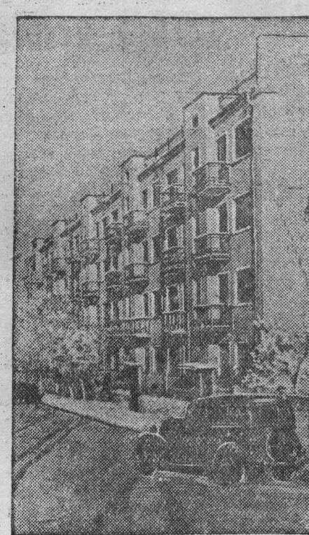
По улицам Ворошилов в Коммунальном отделе отремонтирован ряд домов. При ремонте было сделано много работ по переоборудованию комнат, проведена горячая вода, поставлены ванны.
