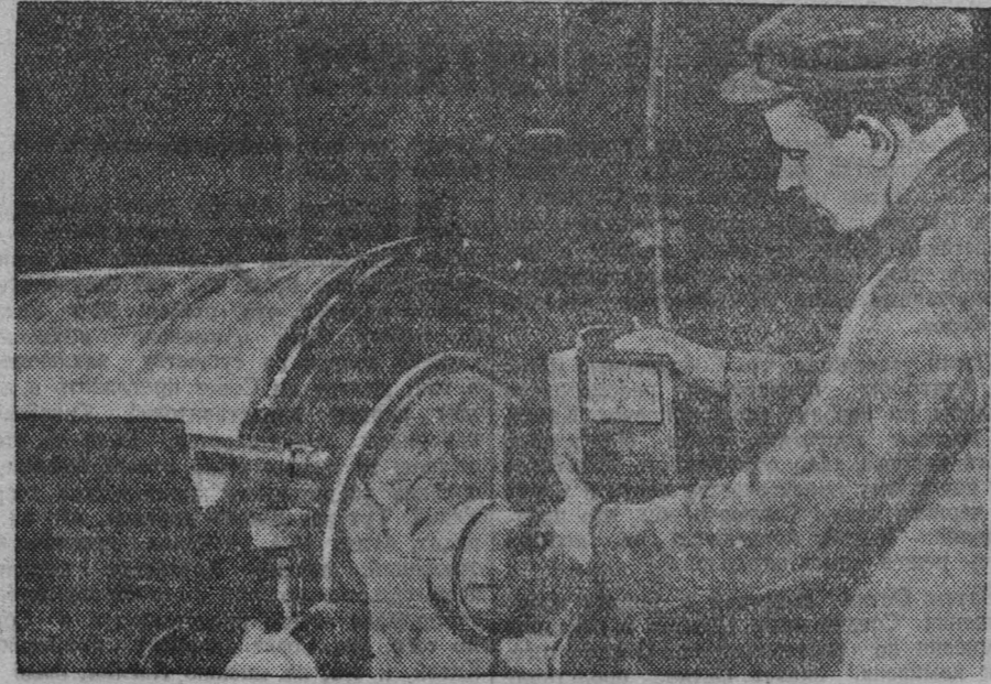
Сепараторщик Мундыбашской аглофабрики Трофим Андреевич Романов — старейший рабочий на предприятии. Его артегаты всегда в образцовом порядке, работают без перебоев. На снимке: тов. Романов за проверкой магнитного поля в барабане. Фото В. Булычева.
