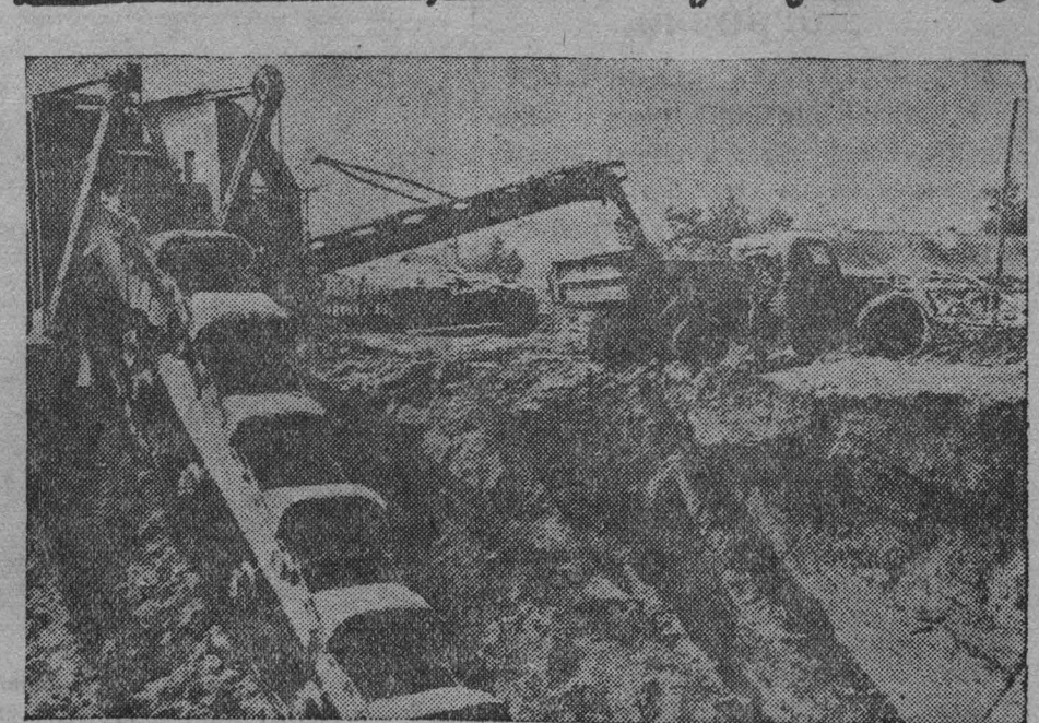
Проклятые. В центре города, на Артемовской улице, на месте старых деревянных домов закладывается строительство 27-квартирного каменного дома. Все трудоемкие земляные работы механизированы. На отдельных участках уже заложены фундаменты. На снимке: строительная площадка дома. Мощный канализационный коллектор производит рытье котлована под фундамент. Фото А. Смоктуновича.
