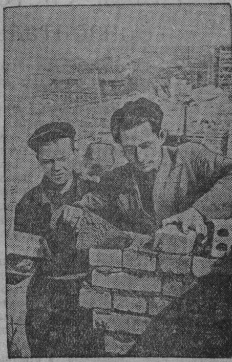
Трест «Сталинскпромстрой». Мастер В. М. Макалин обучает молодого рабочего методам кладки кирпичных стен.
