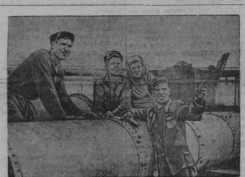
На 150—165 процентов выполняют нормы в дни стахановской вахты мира клепальники из бригады П. И. Синяева в котельном цехе КМК. На снимке (слева направо): клепальщики Г. И. Максимов, М. И. Хасанов, Х. Штакина и бригадир П. И. Синяев. Снимок А. Акулова.
