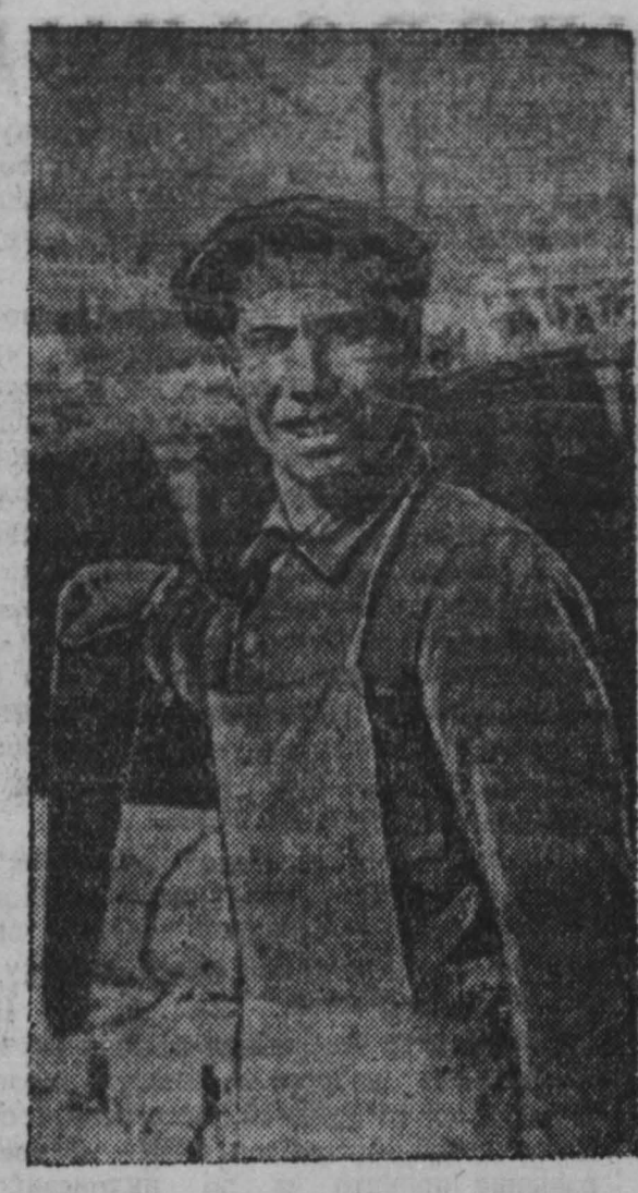
На строительстве дома химвкомбината по Советской ул. г. Кемерово. На снимке: бригадир комсомольско-молодежной бригады плотников Гиганов Василий Александрович. Он систематически выполняет 1,5 нормы.
