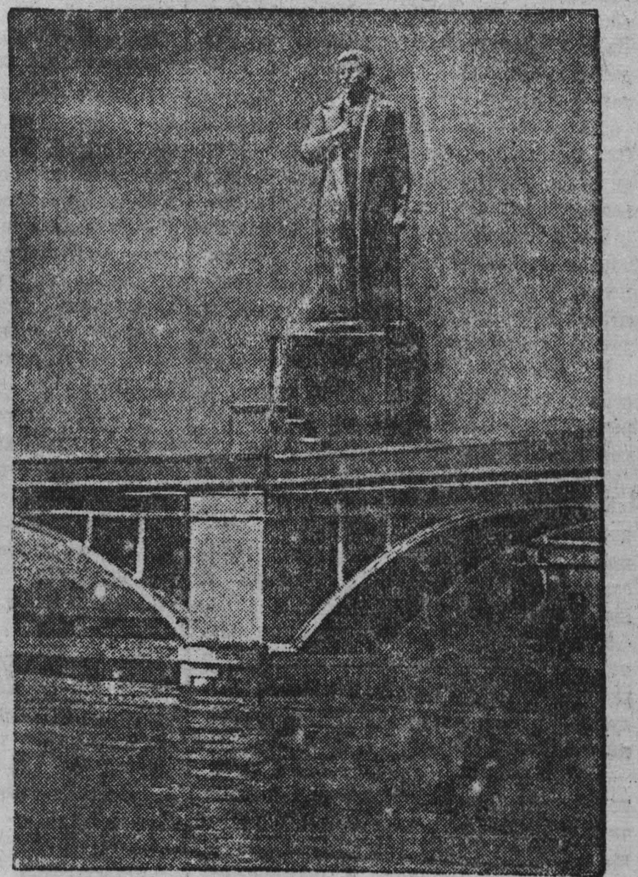
Строительство Невинномысского канала, начатое по заданию товарища Сталина, закончено. В нем принимали участие десятки тысяч колхозников. Население многих сел и станиц Ставрополья, веками испытывавшее нехватку из-за бедствия, получит хорошую кубанскую воду. На снимке: скульптура товарища Сталина на Невинномысском канале.
