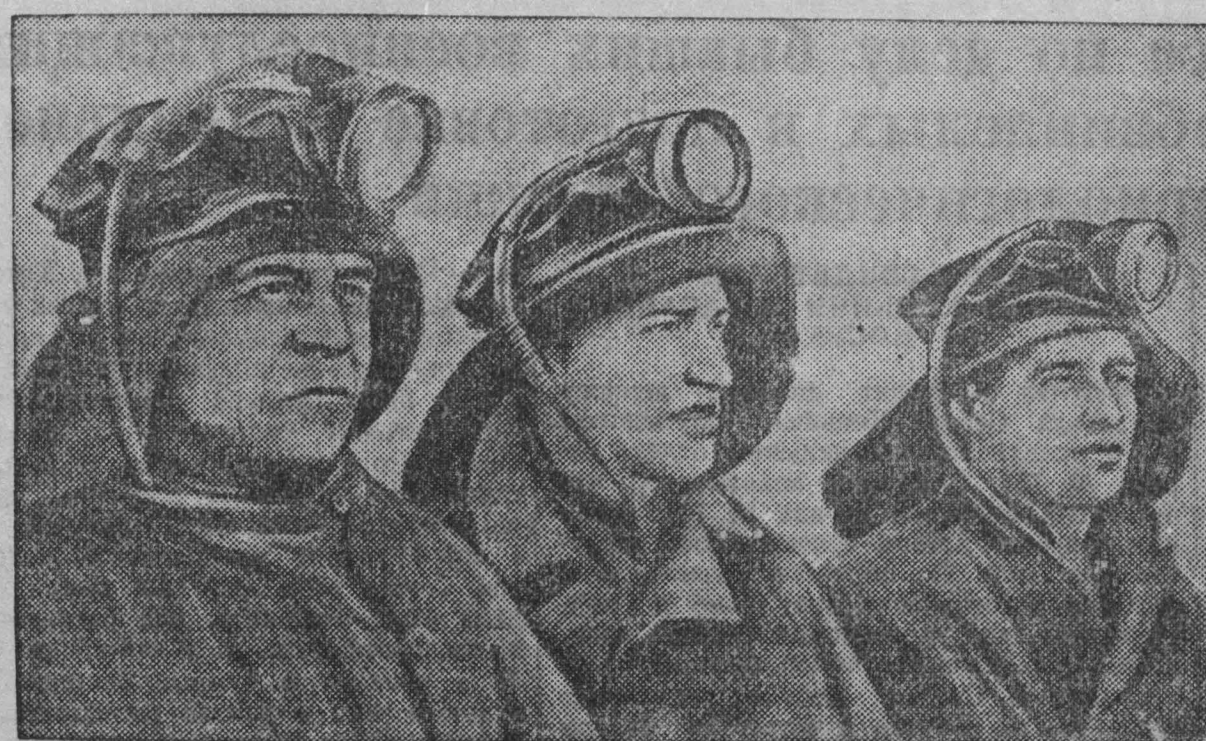
Бригада знатного проходчика Шахабудинова на шахте № 3 треста «Кагоникуголь» одна из первых закончила выполнение годового плана. Сейчас бригада работает в сдвиге 1950 года.
