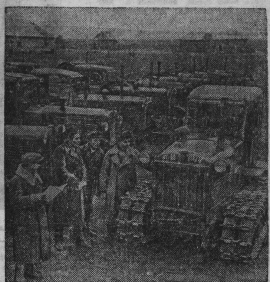
Татарская АССР. Ямыльская МТС первой в республике закончила осенне-зимний ремонт тракторов и прицепного инвентаря. Коллектив МТС провел ремонт по бригадно-узловому методу. Значительную часть деталей в запасных частях механизаторы станции изготовили в своих мастерских. Это дало МТС 20 тысяч рублей экономии. На снимке: приемка отремонтированных тракторов. Слева направо: члены комиссии механик Балтинский МТС С. Гарпов, директор Ямыльской МТС С. Валеев, старший механик МТС А. Хантмиров и бригадир тракторного отряда Х. Шакирянов. Снимок Б. Мясникова.
