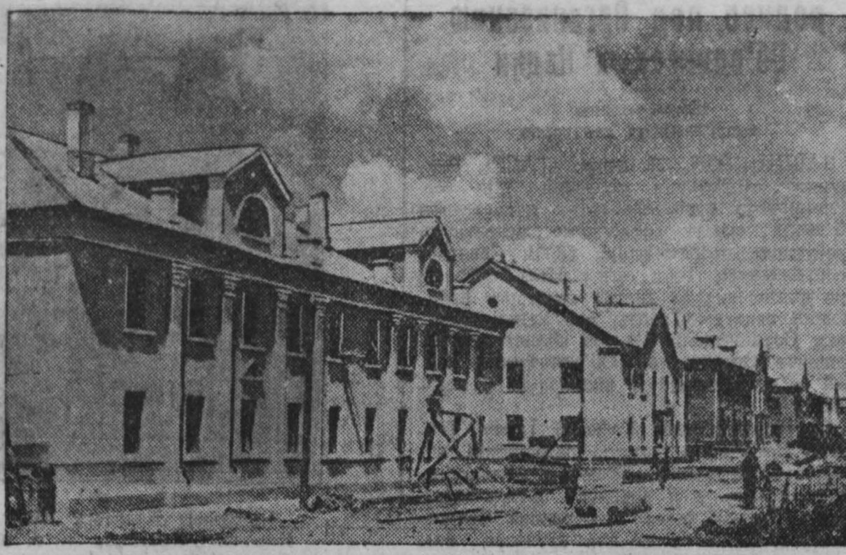
С каждым месяцем все шире развертывается строительство рабочих жилищ в поселке шахты «Красногорская».
