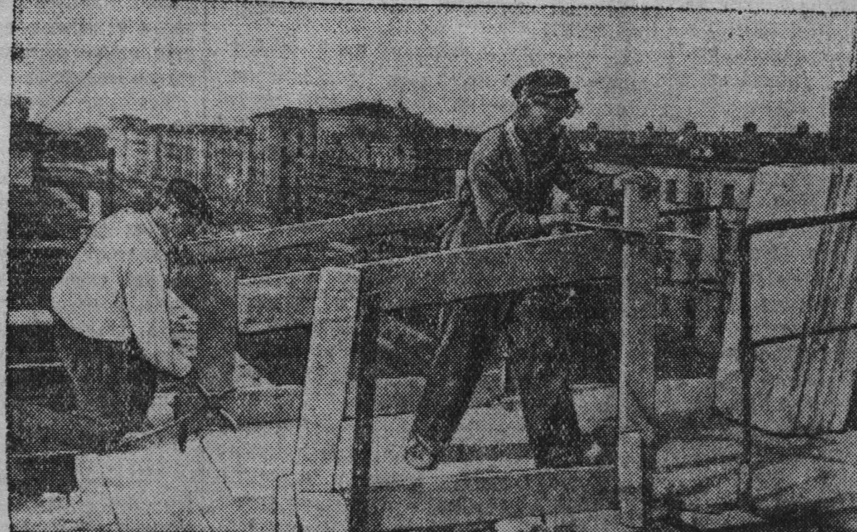
В Сталинске идет комплексная застройка квартала жилых домов на проспекте имени Молотова. Здесь сооружается 24 дома, по 44 и 65 квартир в каждом. Дома строятся по проекту архитектора Н. А. Бровкина.
