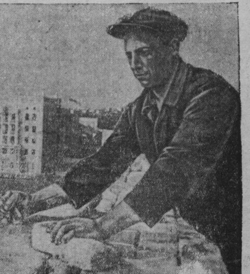
Сталинград. Быстрыми темпами идет строительство и восстановление зданий. Построено много жилых домов, школ, детских садов и др. Только за 4 месяца текущего года введено в эксплуатацию более 17 тысяч квадратных метров жилой площади.
