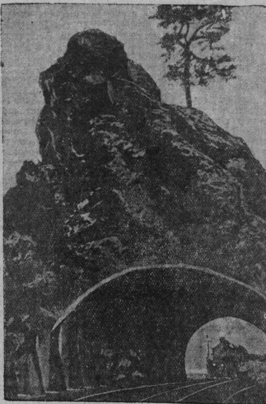
На снимке: один из многочисленных тоннелей на Кругобайкальской железной дороге.
