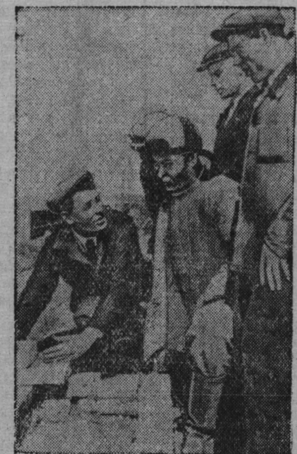
Очередной стахановский «четверг» газеты «Кузбасс» в Киселевске состоялся на рабочем месте знатного каменщика Н. И. Кожемякина, который на практике показал строителям Тайбинского поселка новый скоростной метод кладки облегченных стен.
