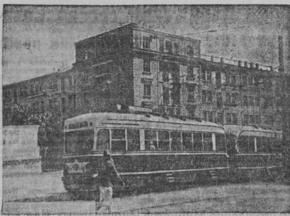
В центре города Кемерово на углу улиц Советская и Кирова сооружено пятиэтажное здание, заканчиваемое отделкой. Это — новый жилой дом, отстраиваемый для рабочих Новокирбината.
