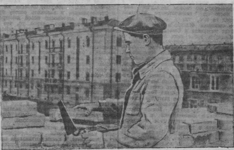
Стахановец-каменщик 4-го стройуправления треста «Сталинскрестрой» Д. Мельник на кладке стен жилого дома нового квартала на проспекте имени Молотова в г. Сталинске. Тов. Мельник выполняет не менее полутора норм в смену. Фото Н. Никитина.
