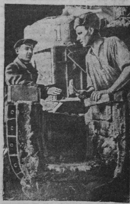
Кузнецкий металлургический комбинат. Коллектив 2-го маргеновского цеха — лидер предамского социалистического соревнования. Мастер ковшевого хозяйства Г. А. Кабанов в марте полностью обеспечил высокопроизводительную работу сталеразливочной машины цеха на 128 процентов. На снимке: тов. Кабанов (слева) и лучший каменщик И. Малюк за ремонтом стального жолоба. Фото В. Бульчева.
