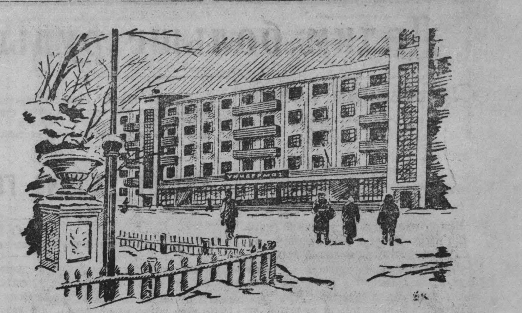
Город Сталинск. Здание универмага. Рис. Е. Смирнова.
