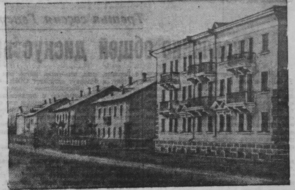
Застройка нового района г. Сталинска. Совсем недавно на левой стороне диагонального шоссе, что идет от вокзала к заводу, было несколько временных барачков. Сейчас там построено более 20 красивых двухэтажных жилых домов, здание управления «Гавкузбасснахтострой». На снимке: жилые дома нового района г. Сталинска. Фото В. Булычева.
