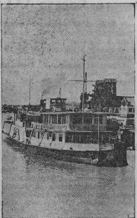
На судоремонтных заводах Западно-Сибирского речного пароходства строятся пароходы для Обского бассейна.
