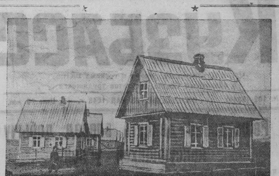
Строительная площадка будущей ГРЭС Южного Кузбасса обживает. Растет рабочий поселок. Домик за домиком вступают в строй, заселяются строительные станции.
