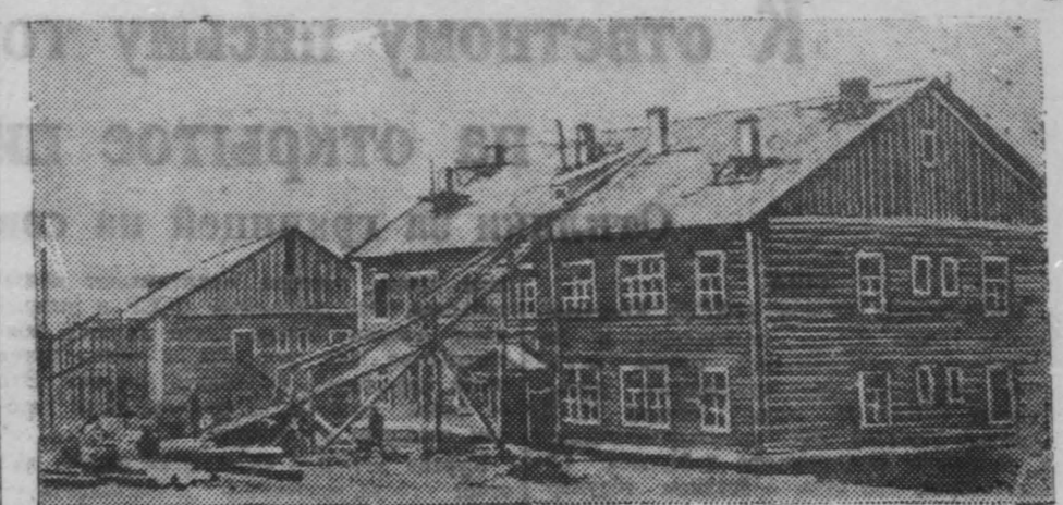
На шахте «Капитальная» треста «Молотовуголь» заканчиваются строительством два 8-квартирных дома для горняков. На снимке: на стройке 8-квартирных домов. Фото В. Булычева.
