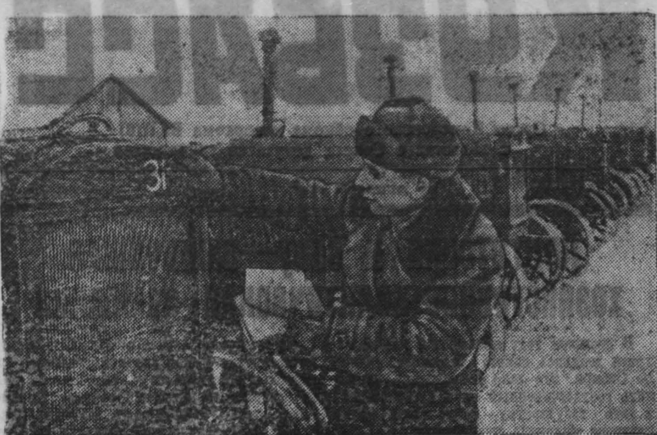
Атнинская МТС Татарской АССР перевыполнила план тракторных работ 1946 года, обработав сверх задания 6.500 гектаров. Сфотографировано 24 тонны горючего. Коллектив МТС первым в республике закончил зимний ремонт тракторов. На снимке: контролер-механик Атнинской МТС Г. Шарифов ставит хозяйственные номера на отремонтированных тракторах. (Фотохроника ТАСС).
