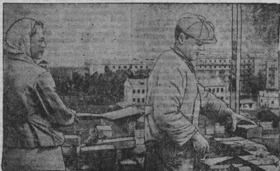
На строительстве 140-квартирных жилых домов для кузнецких металлургов. Каменщик тов. Лазаренко выполняет дневное задание на кирпичной кладке на 170—200 процентов. На снимке: тов. Лазаренко и его подручная тов. Ненашева.
