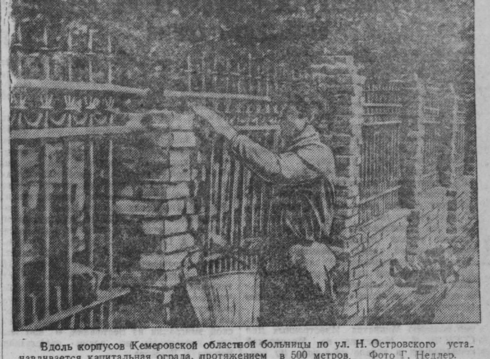
Вдоль корпусов Кемеровской областной больницы по ул. Н. Островского устаивается капитальная ограда, протяжением в 500 метров. Фото Т. Неллер.
