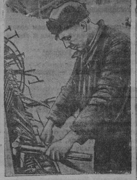
Прокопьевская МТС. На снимке: лучший слесарь-комсомолец тов. В. Соколов за ремонтом культиватора. Он выполняет смежное задание на 250—300 пуд.
