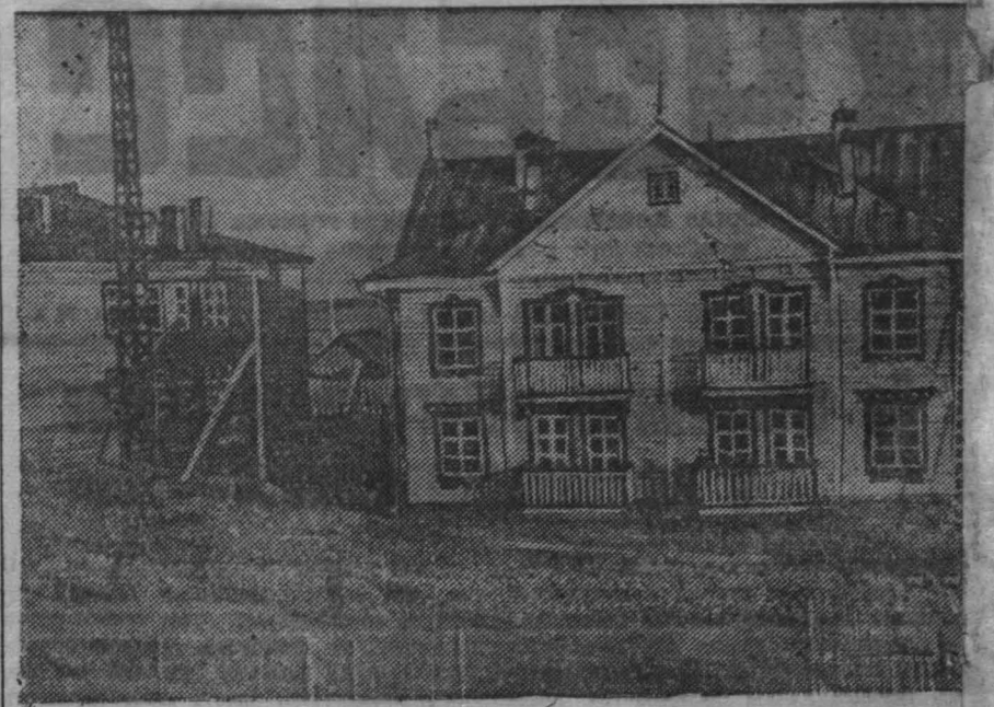
По плану новой пятилетки на Гороблагодатском руднике (Свердловская область) будет построено 350 двух- и трехэтажных домов для горняков. На снимке: строительство новых домов. (Фотохроника ТАСС).
