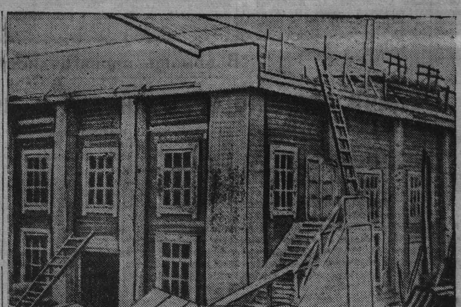
Гор. Ленинск-Кузнецкий. На заводе «Красный Октябрь» закончено строительство и вводится в эксплуатацию новый котельный цех. На снимке: наружный вид котельного цеха. Фото И. Малышевского.
