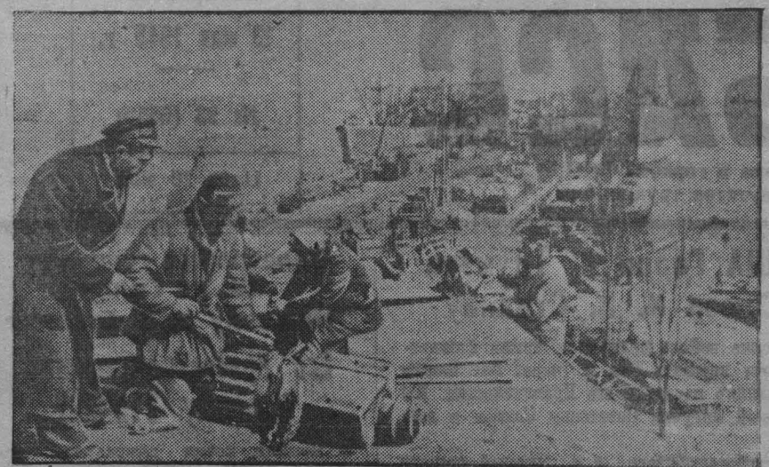
Восстановительные работы в Одесском порту. (Фото ТАСС).
