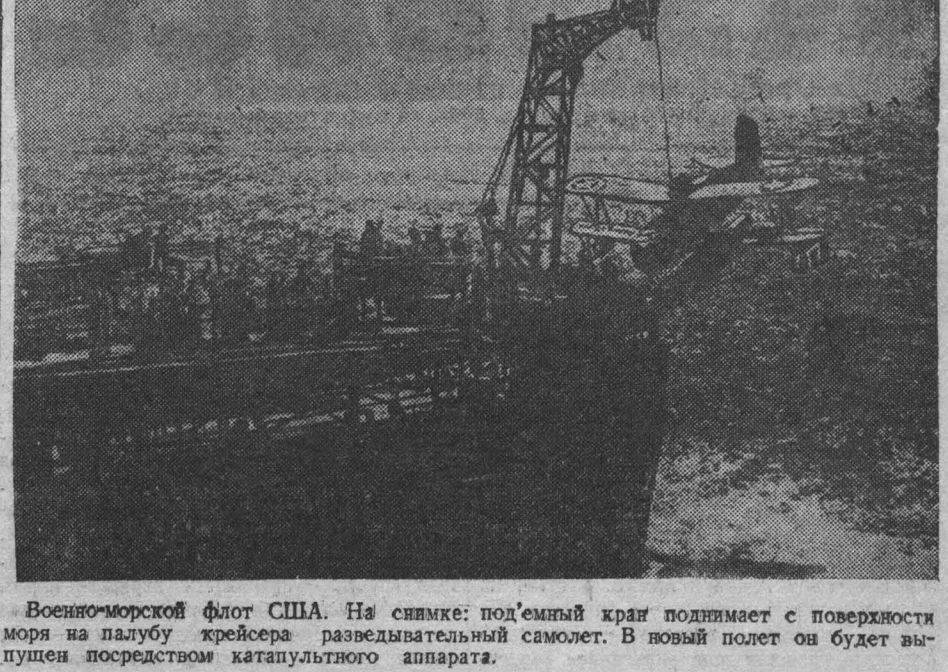
Военно-морской флот США. На снимке: подьемный кран поднимает с поверхности моря на палубу крейсера разведывательный самолет. В новый полет он будет выпущен посредством катапультного аппарата.
