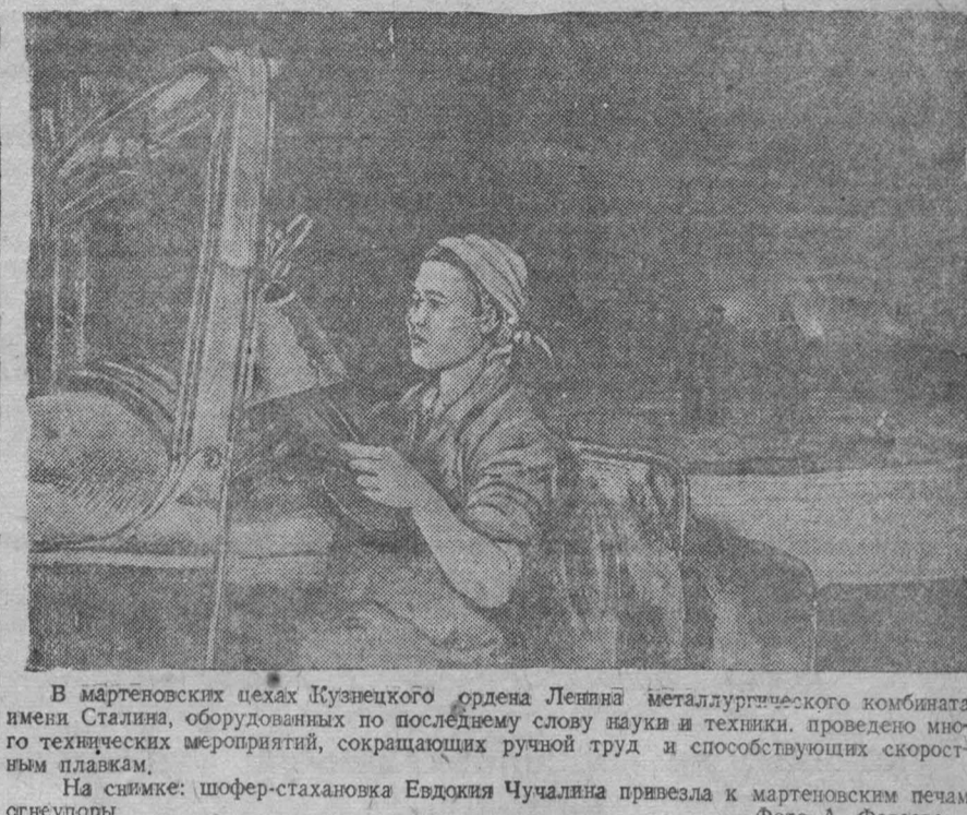
В мартиновских печах Кузнецкого ордена Лепной металлургического комбината имени Сталина, оборудованных по последнему слову науки и техники, проведено много технических мероприятий, сокращающих ручной труд и способствующих экономии металла.
