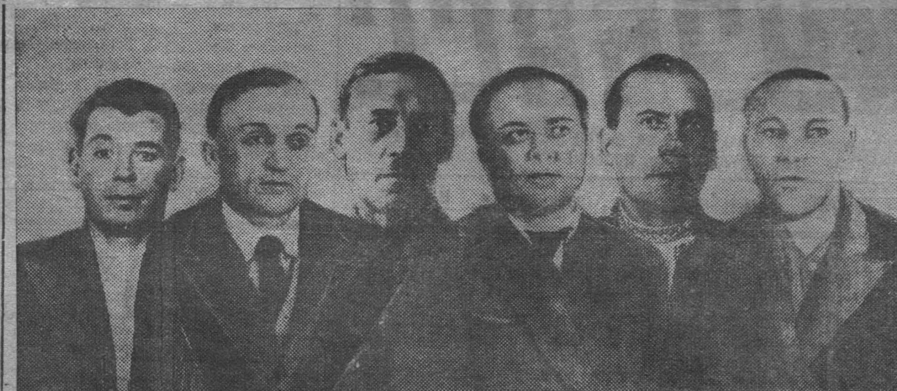
НА СНИМКЕ: бригада Наркомстроя. В первом ряду (слева направо): стахановец, инструктор по штукатурным работам Ф. М. Комаров, руководитель бригады инженер И. К. Бобков, стахановец мастер малярных работ М. И. Виноградов. Во втором ряду: инструктор по кирпичной кладке Н. И. Кожемякин, инструктор по старторно-плотничным работам Ф. С. Муравьев, инструктор по санитарно-техническим работам П. Н. Никитин. Бригада прислана в Кемерово для передачи опыта скоростного строительства. Фото Г. Носков
