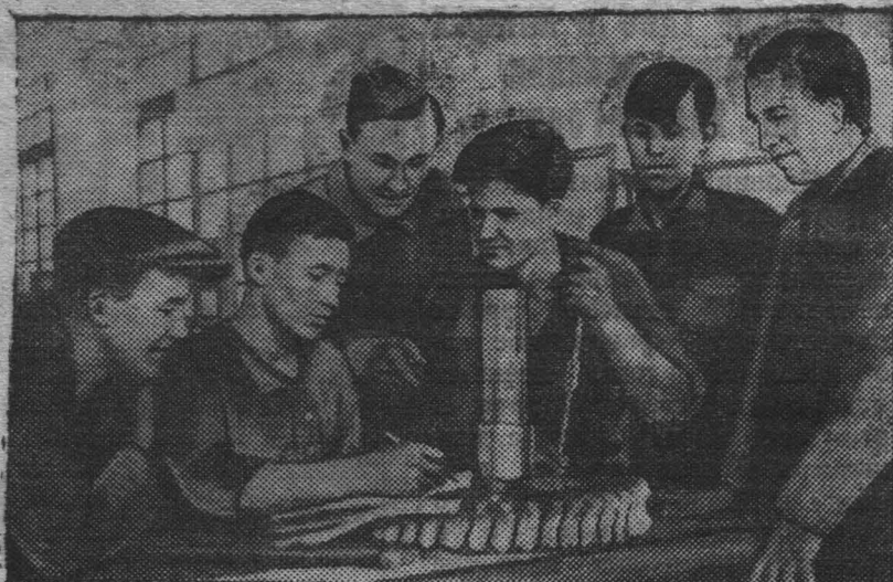
Лучшая монтажная бригада механического завода Кузбассугля, выполняющая производственное задание по новым нормам до 125 проп. На снимке: слева направо — Размахов В. И., бригадир Евсеев Л. В., Пыжынов В. А., Конев В. М., Сизов П. Г., Севастьянов А. во время бригадного совещания. Фото С. Табашнева.
