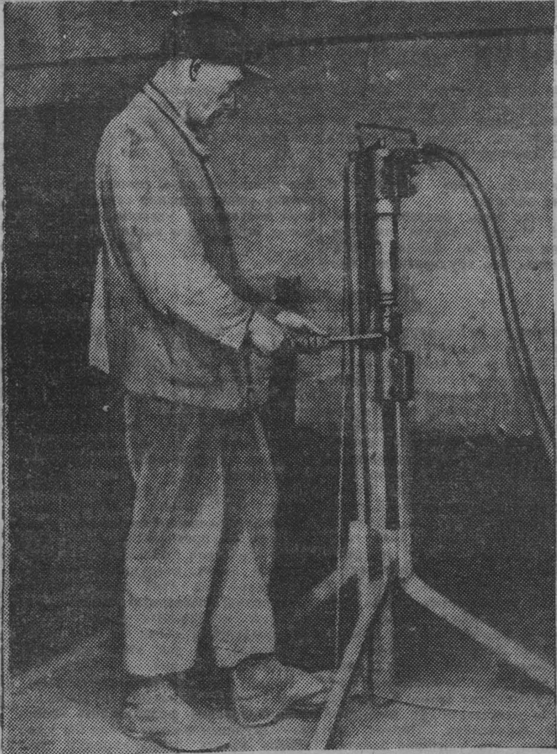
Слесарь ремонтно-механического цеха шахты «Центральная» коммунист тов. Черномазов, внес несколько рационализаторских предложений и изобретений по механизации шахты. На снимке: тов. Черномазов у изобретенного им станка для подкачки болтов и глухарей. Фото: С. Табашева.
