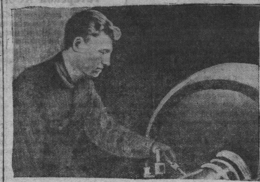
Лучший токарь, он же агитатор депо станции Кемерово, тов. Гришин Д. А., выполняющий производственное задание на 272 процента. НА СНИМКЕ: Гришин Д. за обработкой шеек колесных пар. Фото Табашева.
