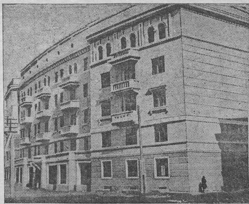
Строительство большого Кемерово. Вновь выстроенный жилой дом № 16 на Притомском участке. Фото П. Мусюк.
