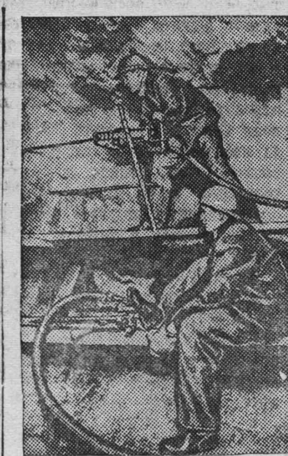
Бригада знатного стахановца-буржика тов. Баталова (капитальная шахта № 2 «Детгостроймелурда», Свердловская область), применяя проходку в два яруса, выполнила январскую программу на 189,8 процентов. На снимке: Двухъярусное бурение по методу тов. Баталова.
