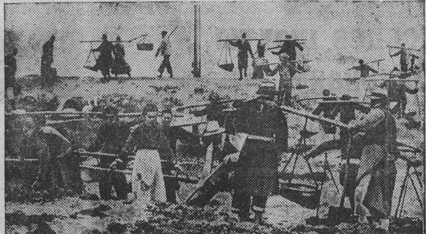
К военным действиям в Китае. Японские захватчики заставляют население оккупированных ими районов выполнять непосильную работу. На снимке: Китайское население на земляных работах в районе Шанхая. Фотохроника ТАСС.
