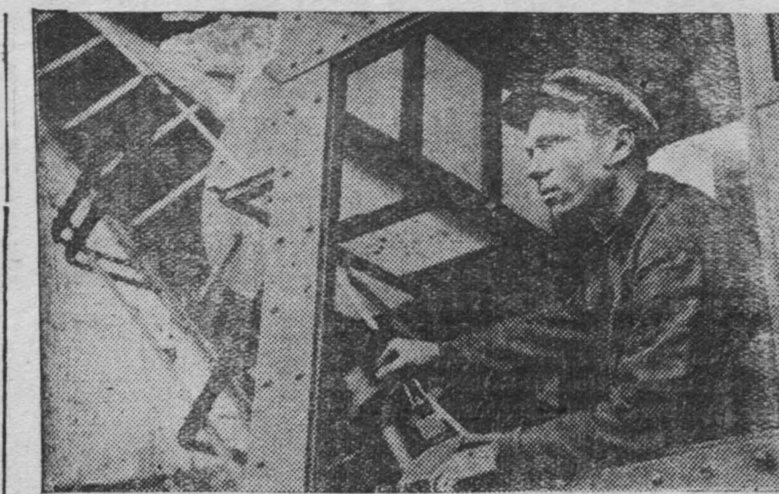
Челябинский угольный бассейн. На снимке: стахановец машинист экскаватора разреза № 2, треста «Коркинуголь» П. П. Черепанов, перевыполнивший сменные нормы: при задании 1180, выдал 1600 кубометров. Фотохроника ТАСС.
