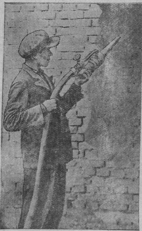
НА СНИМКЕ: Тов. Зайцев работает растворомнасосом. Фото Малышевского.
