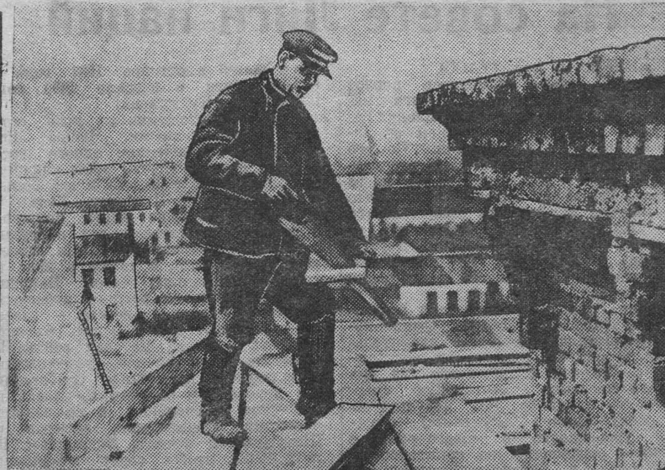
На снимке: стахановец-бригадир А. И. Лапин. Под его руководством бригада плотников, работающая на строительстве жилых домов 5 участка КТС, выполнила апрельское задание на 221 процент.
