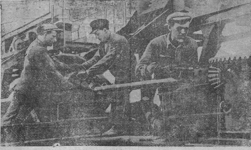
Рабочие, инженерно-технические работники шахты „Северной“ развернули борьбу за скорейший пуск шахты. На снимке: бригада монтажников за сборкой оборудования поверхностного механизма. Справа налево — бригадир К. Ф. Крапов, В. М. С. Мохов и Н. А. Басильев. Бригада тов. Крапова на сборке оборудования добились повышения производительности труда на 400 процентов. Фото Малышевского.
