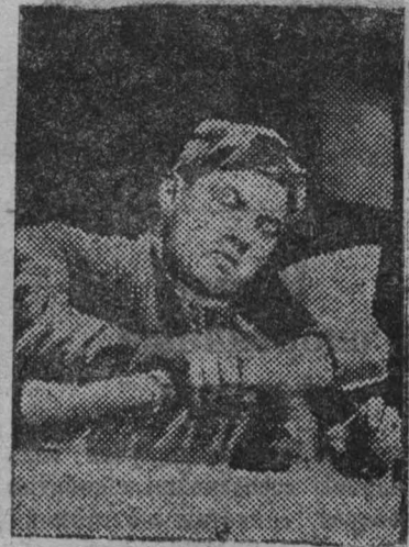
Стахановец Азотсвоя т. САФРОНОВ устанавливает леса.
