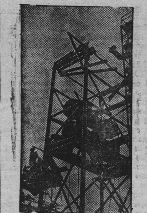
На строительстве Саратовского кренинг-завода. На снимке: монтаж 8-го кренинга — блока.
