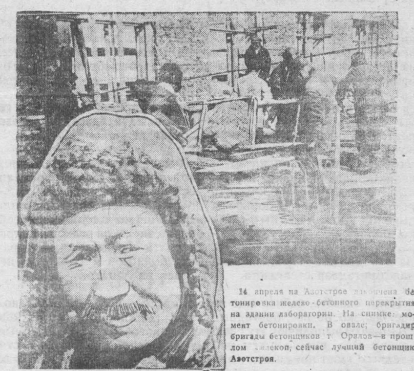
14 апреля на Азотострой закончена 26-тонная железобетонная перекрытия на здании лаборатории. На снимке: момент бетонирования. В овал: бригадир бригады бетонщиков т. Орлов — в прошлом — отличник, сейчас — лучший бетонщик Азотострой.
