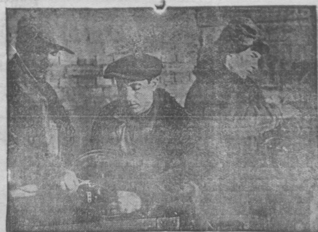
Электромонтажники бригады Начухова (Углеперогонка) за монтажом электрооборудования
