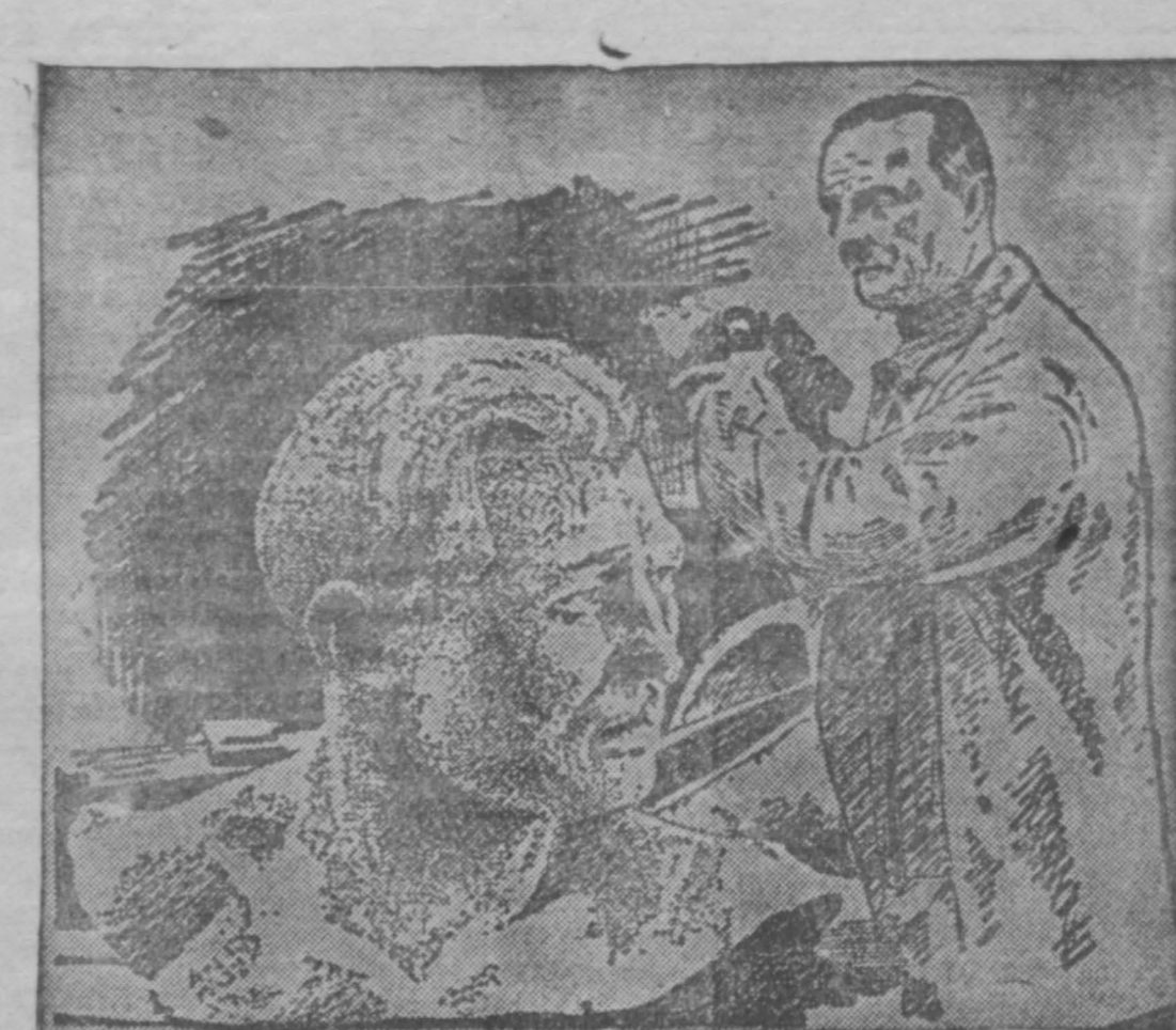
На строительстве алма-тинского Дома культуры: скульптор тов. И. Вские за работой.
