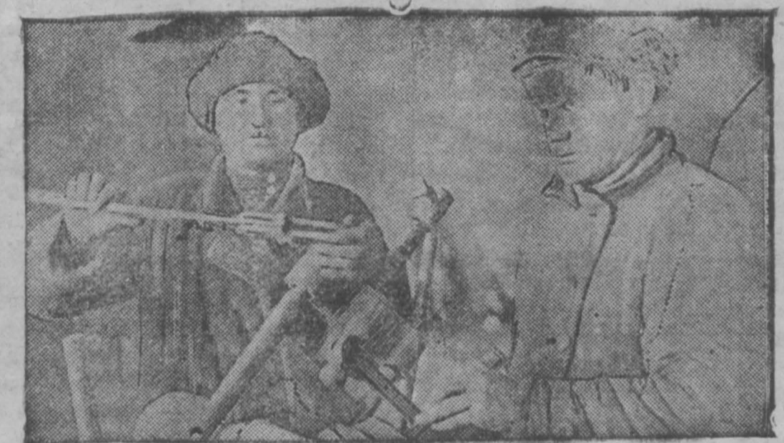
Ремонт паропроводов на коксохимзаводе. На снимке: ударники тт. Жданов и Леонтьев за проведением ремонта.
